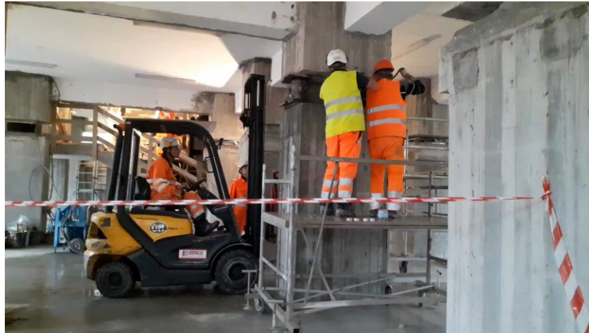
Fase 4: rimozione sezione pilastro
